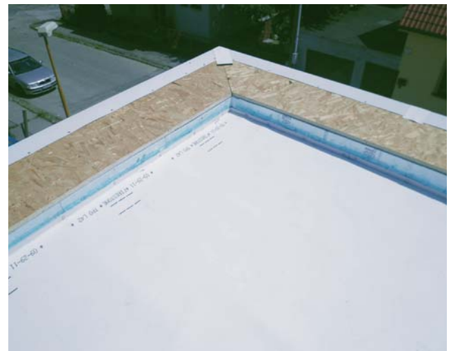
Správna príprava kotvenia PVC fólie po obvode zateplenej atiky – vodorovná plocha hydroizolácie ukončená na poplastovanom L profile, vonkajší okraj atiky oplechovaný okapnicou z poplastovaného plechu
